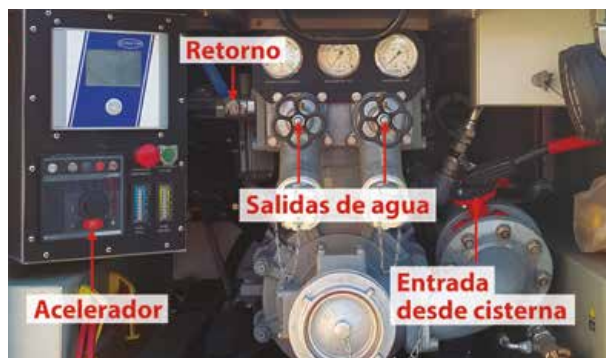
Figura nº 40. Llaves de accionamiento bombas RUBERG
