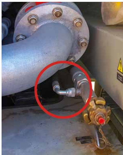
Figura nº 59. Inyección de espuma en salida de alta presión
